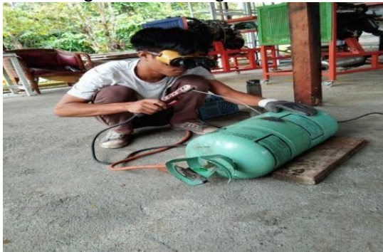
Gambar 2. Pengelasan tabung
