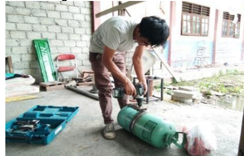
Gambar 4. Melubangi dudukan kompresor dan tabung
