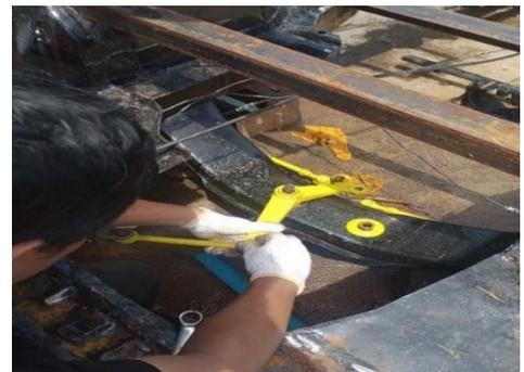
Gambar 9 Pemasangan *long tie rod* dengan *center arm*
