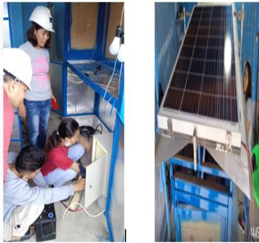
Gambar 2. Pemasangan Solar cell pada Gerobak Pedagang kaki Lima
