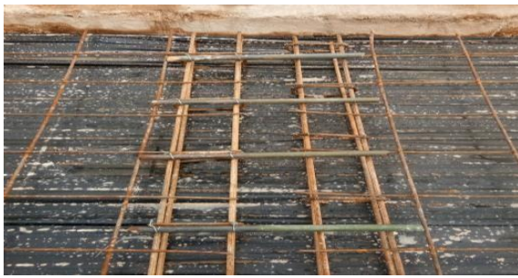
Gambar 2. Pemasangan besi tulangan
