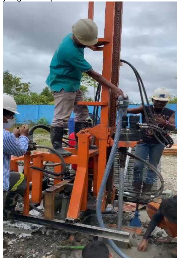
Gambar 1. Proses pembuatan sumur bor menggunakan perumahan rakyat menggunakan mesin bor Jecro 175 sistem hidrolik.
