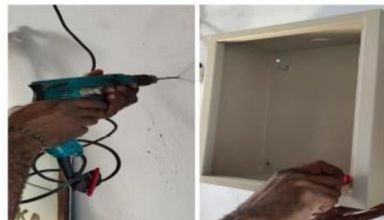
Gambar 4. Proses Pemasangan box panel.
