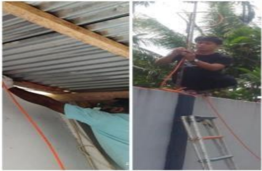
Gambar 6. Proses Pemasangan dan penarikan kabel dari tiang photocell ke box panel.
